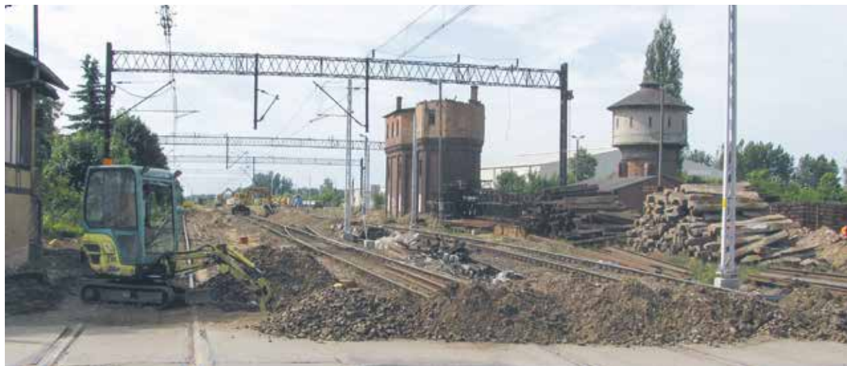
Remont torów utrudnia pasażerom życie, ale po jego ukończeniu pociągi pojadą szybciej.
