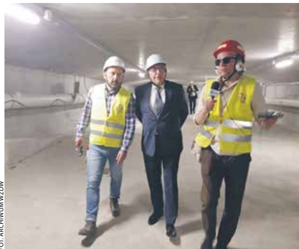
Wicemarszałek wewnątrz mostu w towarzystwie kierownika budowy i dziennikarza Radia Poznań.
