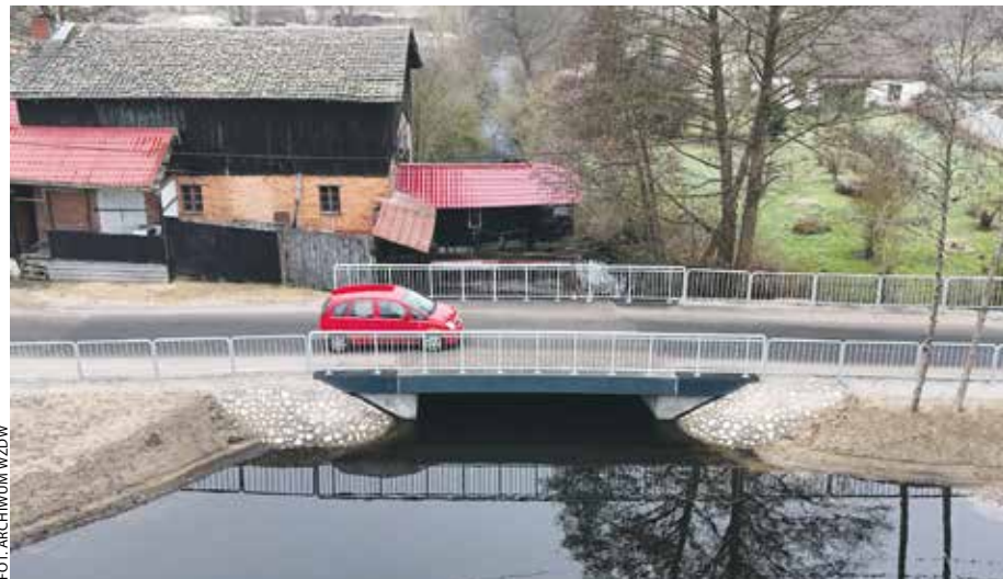
Przy remoncie mostu w Kamienniku zastosowano innowacyjną technologię.
