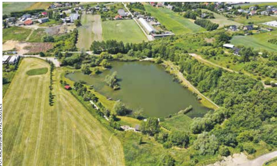
Jednym z przedsięwzięć objętych dofinansowaniem z unijnego Programu Rozwoju Obszarów Wiejskich na lata 2014-2020 był projekt „Uporządkowanie gospodarki wodno-ściekowej na terenie gminy Przygodzice – II”.
