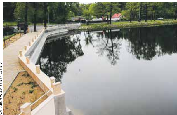
Modernizacja zbiornika „Szperek” w Antoninie.
