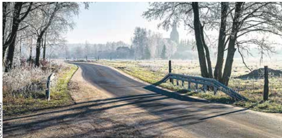
Przedstawiciele samorządów lokalnych zwracają uwagę na potrzebę dalszego inwestowania w podstawową infrastrukturę na obszarach wiejskich. Na zdjęciu droga w miejscowości Batorówko w gminie Lipka w powiecie złotowskim, zmodernizowana dzięki PROW 2014-2020.
