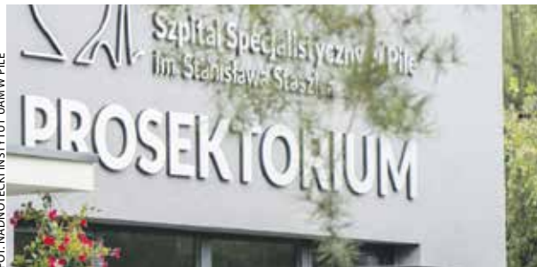
Nowy obiekt otwarto w Pile 8 września.
