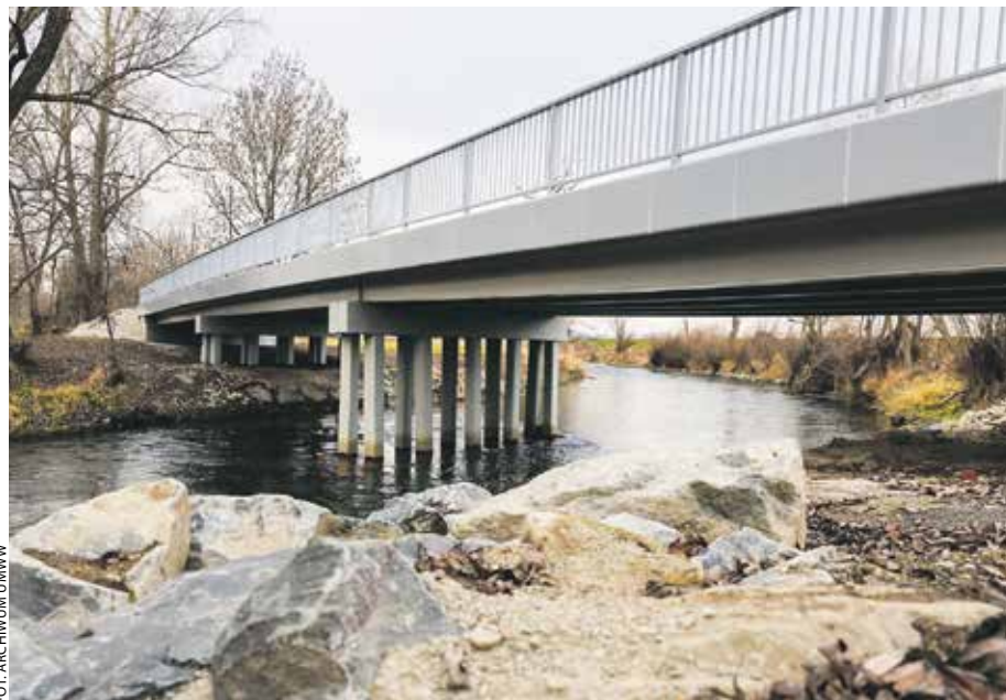
Odbudowany most w Boboluszkach nad rzeką Opawą łączy Polskę i Czechy.
