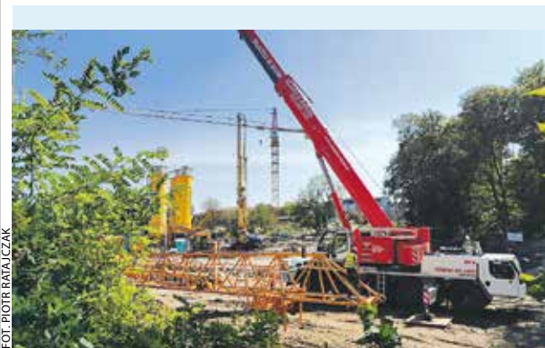
Obecnie przy ul. Północnej prowadzone są mało efektowne dla oka prace ziemne.
