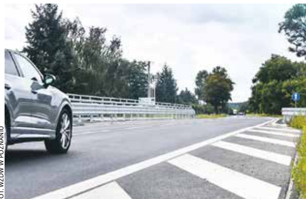
Przebudowano fragment kluczowej trasy.
