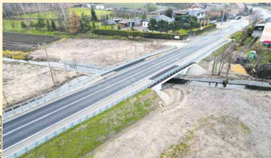
Nowy most na rozbudowanym odcinku drogi w miejscowości Lubinia Mała.
